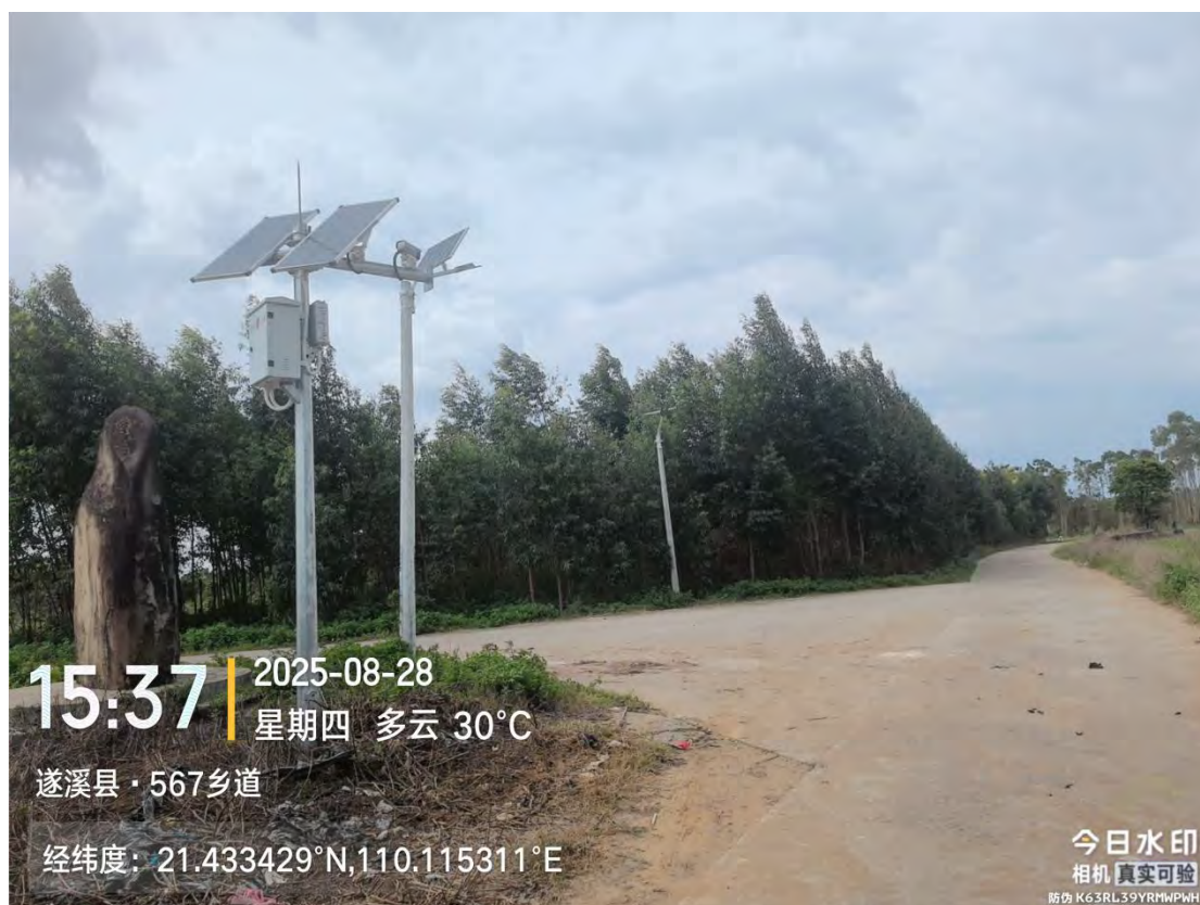
图 3-7 X567 桐油村和东边村路口现场照片
