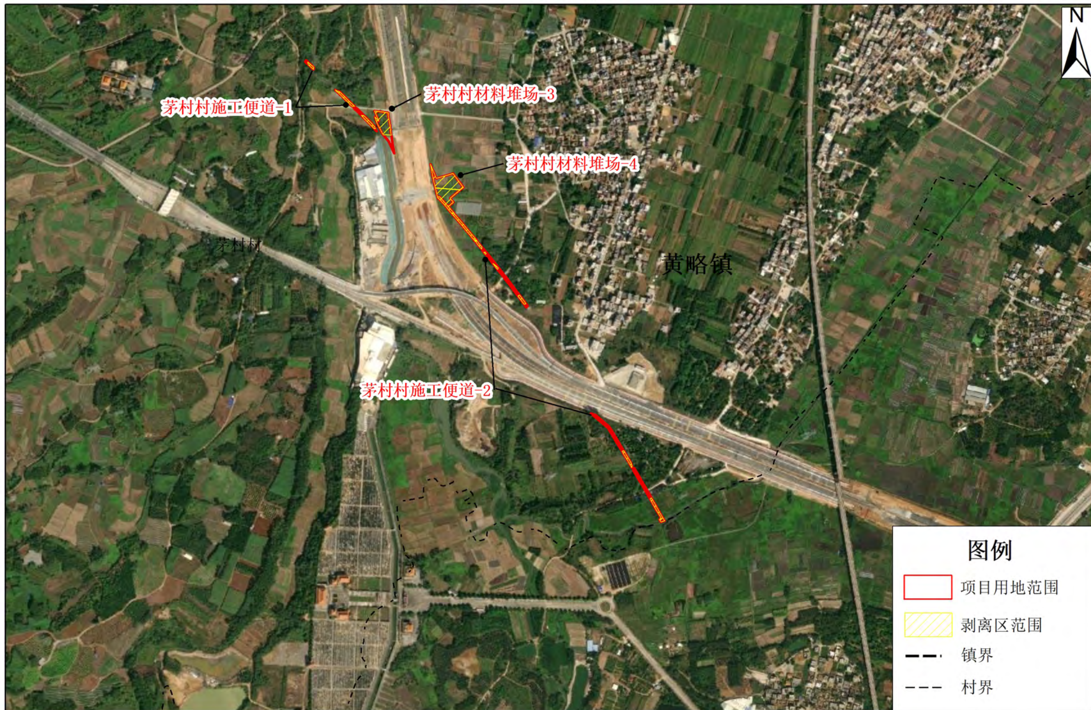
新建合浦至湛江铁路（广东段）站前工程HZGDSG-2标材料堆场和施工便道（遂溪段） 耕作层剥离区影像图十一
